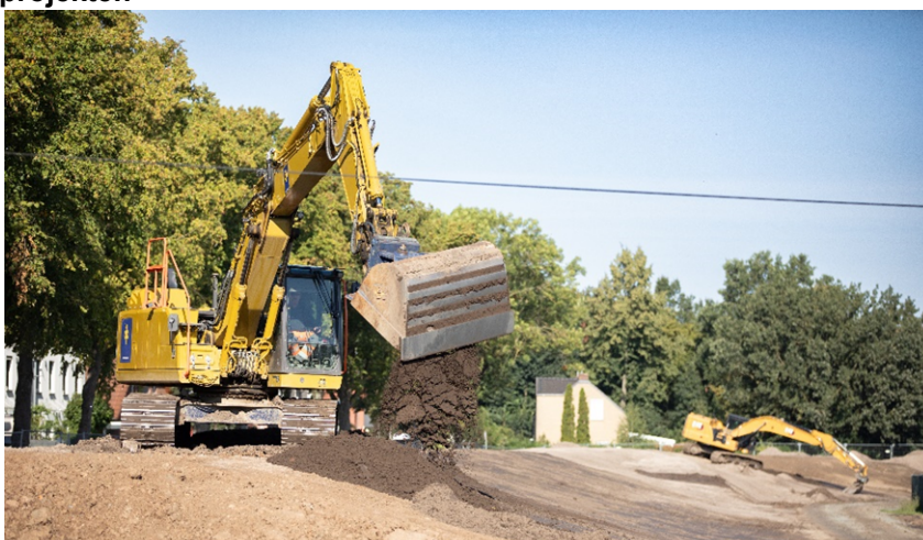
Abbildung 1: Das Deichbaumaterial „Klei“ wird beim Deichbauabschnitt in Rablinghausen mit Großgerät eingebaut.
