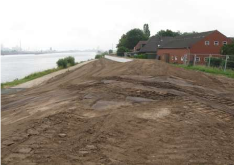
Erddeich vor der Ansaat, im Hintergrund die neue Hochwasserschutzwand
