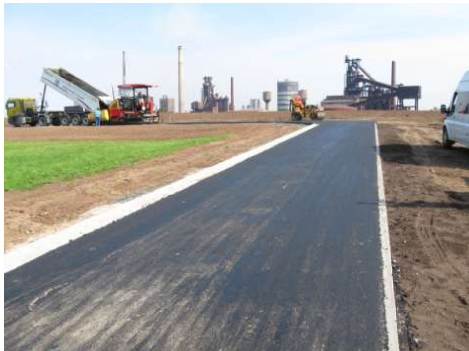
Neubau und Anschluss des Deichverteidigungsweges an die Straße „Glockenstein“
